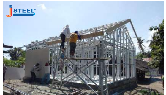
Rehabilitasi Gempa Lombok
