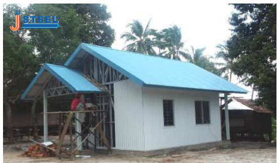
Rumah Prefab Kepi - Papua
