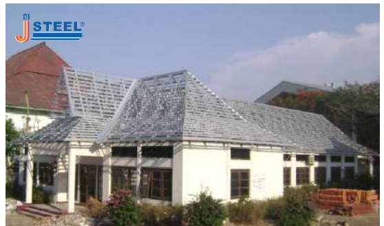
Gedung Koni - Cirebon
